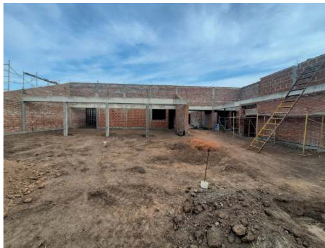
Trabajos de construcción de la sede Casita del Niño Rincón del Sol.
