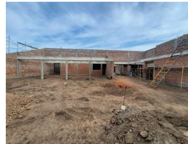
Travaux de construction du siège de la Casita del Niño Rincón del Sol.
